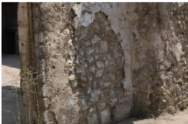
Fig. IV-42. Fotografia disgregazione ©UNESCO
