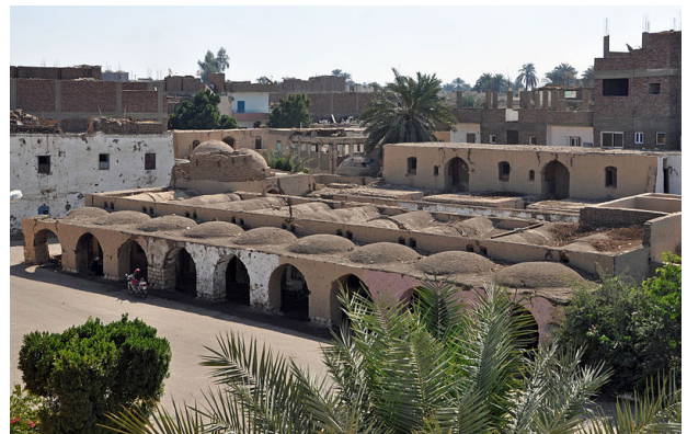
Fig. II-22. New Gourná @DevenirArchitecte
