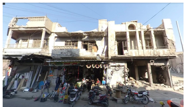
Fig. III-13. Casa vicina del complesso Al-Nuri @ Google maps commons
