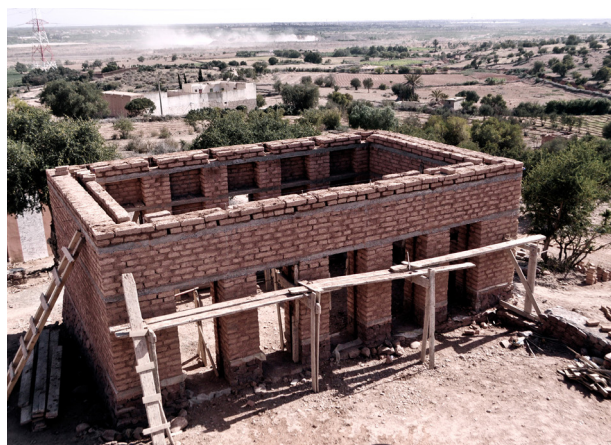
Fig. VI-41. Scuola in costruzione ©BCarchitects
