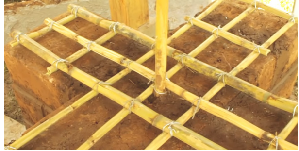
Fig. VI-20. Armature di canna in angolo ©ASF
