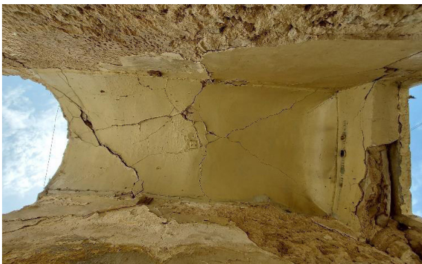
Fig. IV-85. Soffito a volta dell'ingresso @UNESCO
