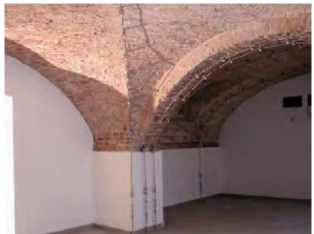
Fig. IV-87. Rinforzo con cavi pretesi @P. Napoli
